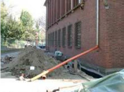
zum Fundament ausgehoben und neu versiegelt werden. Bei dieser Gelegenheit wurden auch die Außenrohre und ein neuer Schacht angelegt.
